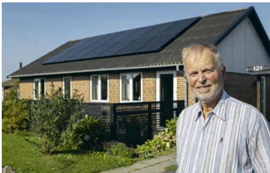
Formand Kai Munch foran et af de otte solcelleanlæg, som har kostet 130.000 kr. pr. hus.
